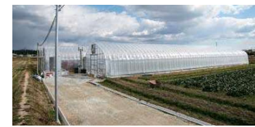
新設したハウスの外観
