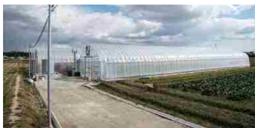
新設したハウスの外観
