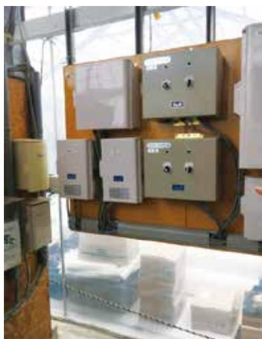
(緊急時の旧制御機器への切替装置)
